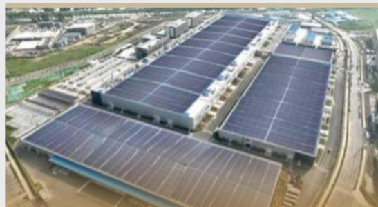
鳳台光伏產業基地2GW光伏組件專案
