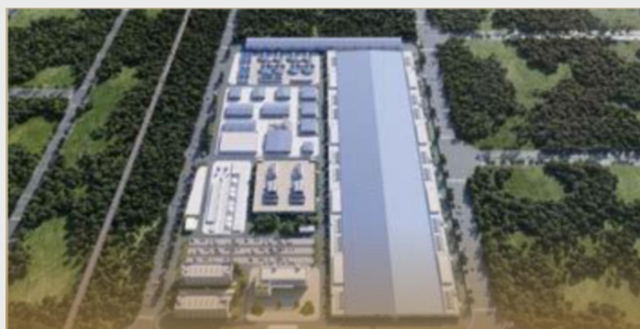
鳳台光伏產業基地6GW n-TOPCon電池
